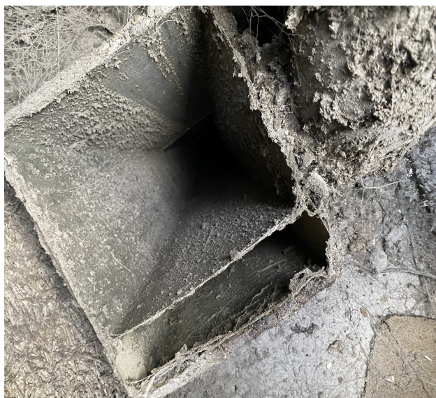
znečištěné potrubí páteřní vzduchotechniky
