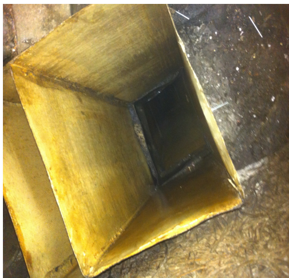
vyčištěné potrubí páteřní vzduchotechniky
